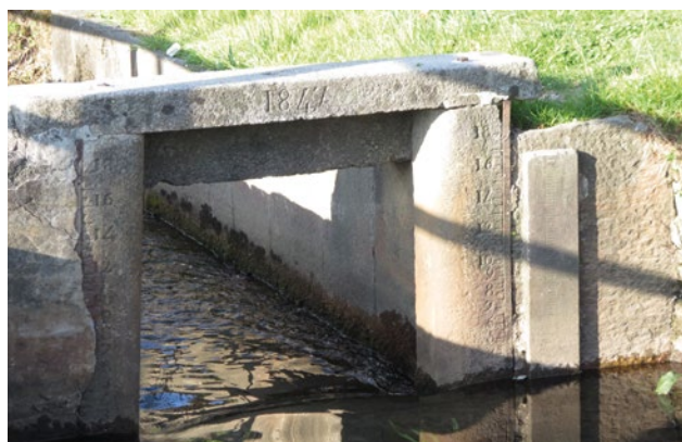
L'antico idrometro di Merone, in provincia di Como, con le tacche che indicano i livelli raggiunti dalla Roggia Gallerana superiore: un tempo serviva per misurare la quantità di acqua che veniva versata nel Lambro, per garantirne una corrispondente captazione nel tratto inferiore finale, utilizzata per irrigare i campi di proprietà dei Gallerani a Carugate. Fonte: Silvano Pirotta.
