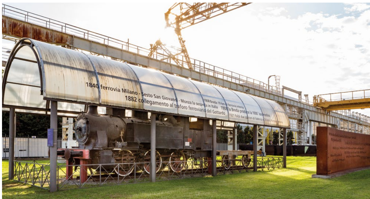
Due immagini del Parco Archeologico Industriale di Sesto San Giovanni. A sinistra: il carro ponte della Breda. Sopra: la Locomotiva Ernesto Breda del 1906.
